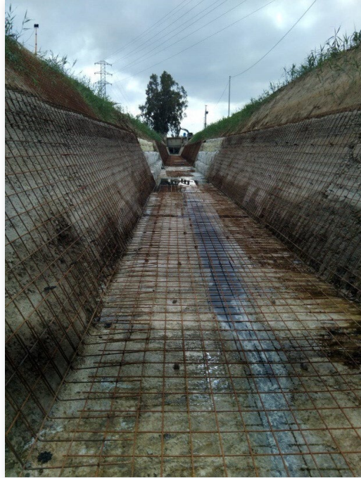
Colocación de ferralla
