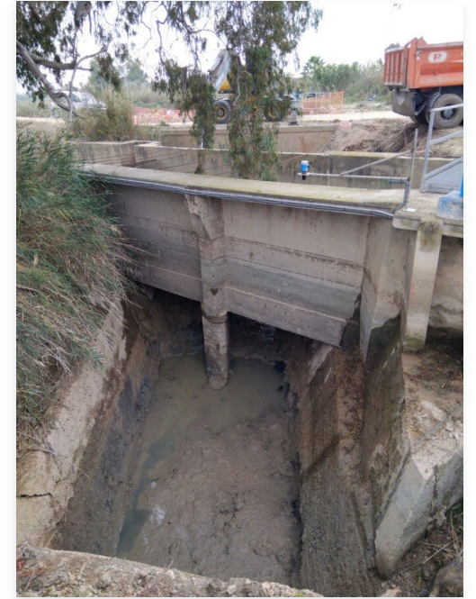
Retirada de lodos del canal
