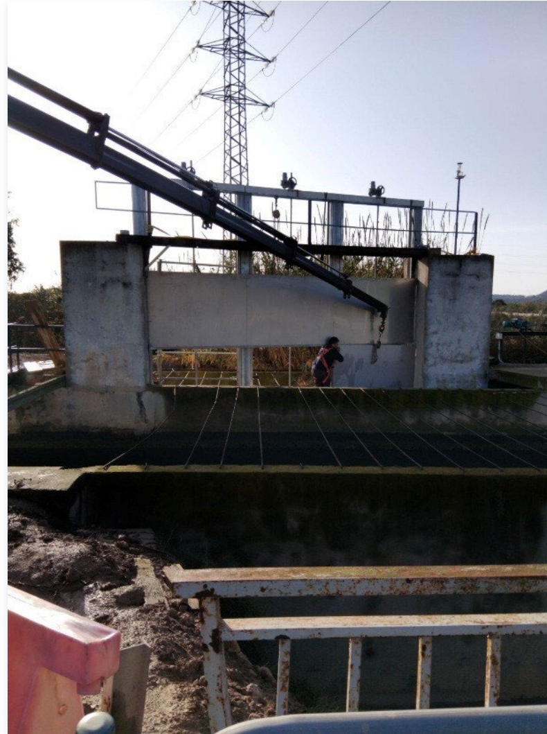
Compuerta de la Reina
