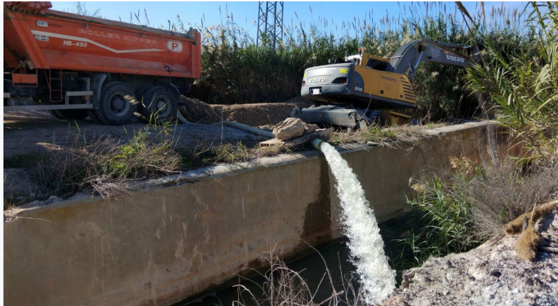
Bombas de achique en la zona de la Reina
