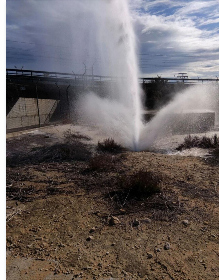
Reparación de la bajante del embalse
