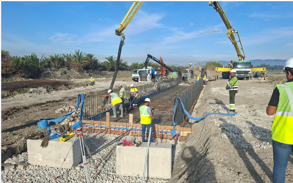
Hormigonado de la losa del nuevo canal
