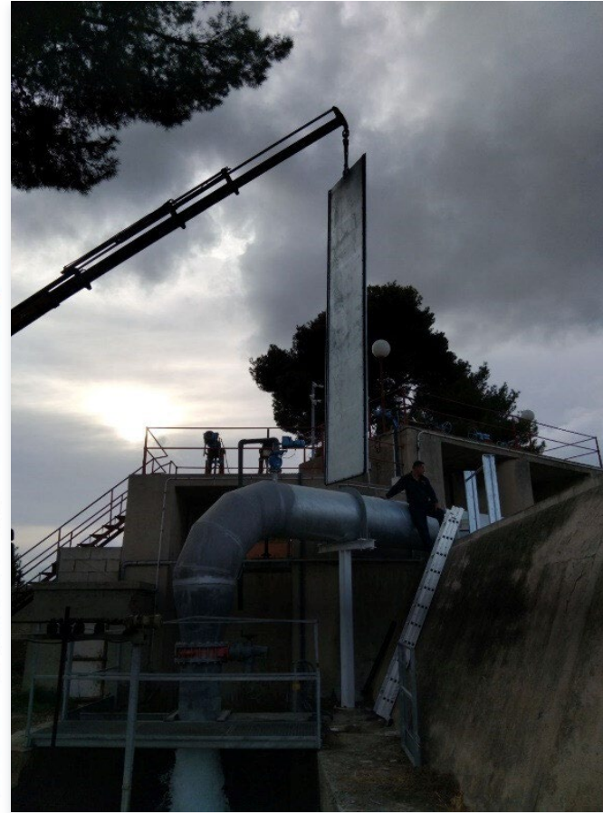
Nueva compuerta de la 5.ª Elevación
